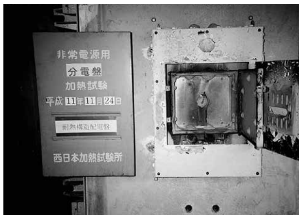
非常電源用分電盤加熱試験
