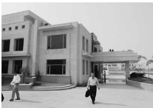
工場建物玄関部分
