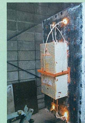
耐熱試験終了直後の 一種耐熱形配電盤等
